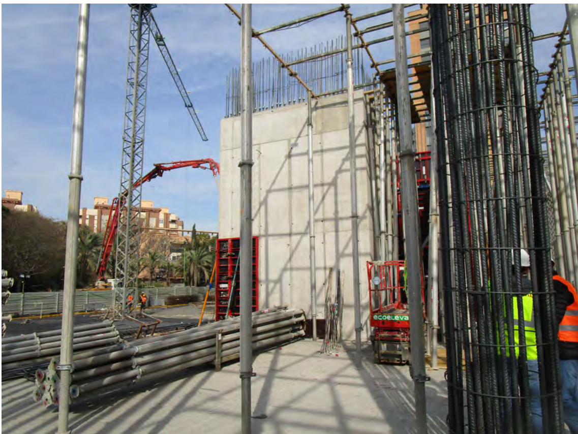
Edificio de Oficinas. Cortes Valencianas 15 - Valencia (estructura)
