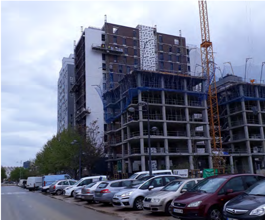
Edificio de 67 viviendas protegidas - Valencia (estructura)
