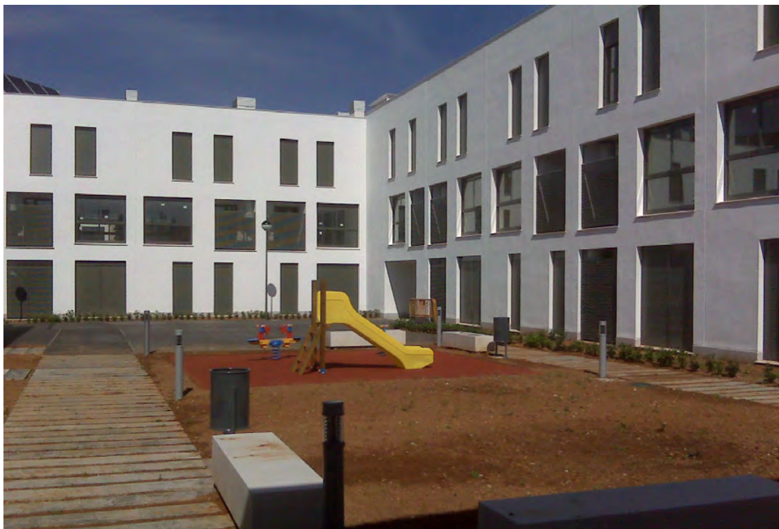
83 VIVIENDAS SAN ANTONIO DE BENAJÉBER – Valencia
