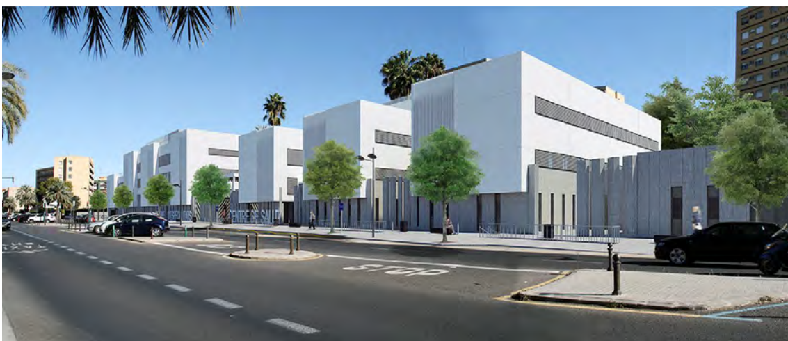
Centro de Salud y Centro de Especialidades Campanar. GVA – Valencia (obras iniciadas)
